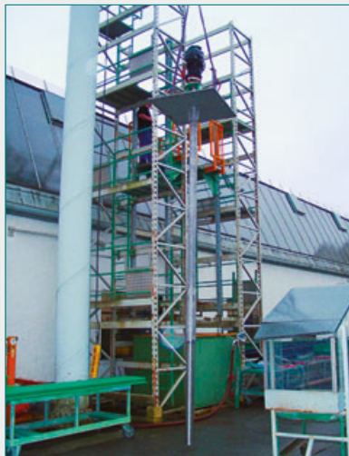
Collaudo di una pompa NEMO® NM045BT prima della spedizione in condizioni di servizio
